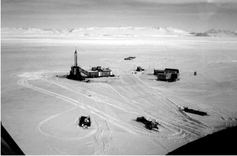
Abb. 9: Forschungsbohrung vom Meer-Eis des zugefrorenen Ross-Meereres bei Cape Roberts. Die Bohrung erreichte eine Tiefe von über 1000 m in den Sedimenten und lieferte u.a. wichtige Daten über die klimatische Entwicklung der Antarktis in den letzten 35 Millionen Jahren. U.a. konnte der Beginn der Vereisung erfasst werden.
